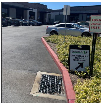
La foto muestra una propiedad muy limpia con un desagüe pluvial que se conecta al sistema de la Ciudad. Esta propiedad está implementando las BMP efectivas.
