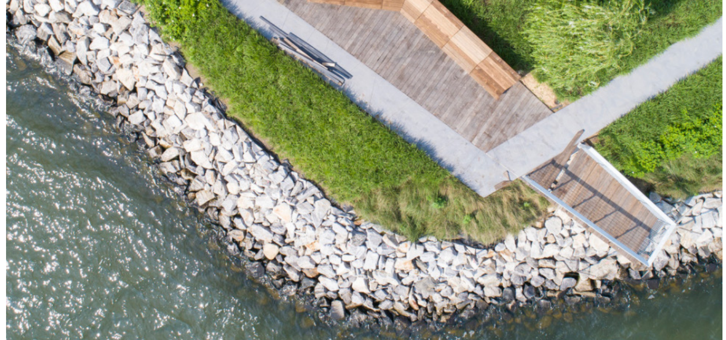
Rip - Rap Edge
