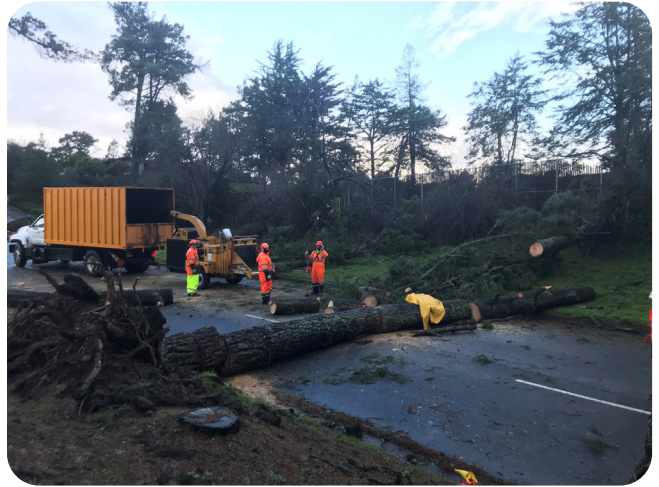
▲ 緊急承包商移除了棵擋住道路的連根拔起的樹。
