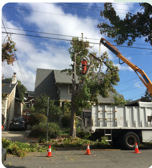
▲ 市政工作人員用重型設備清除一棵危險的行道樹。
