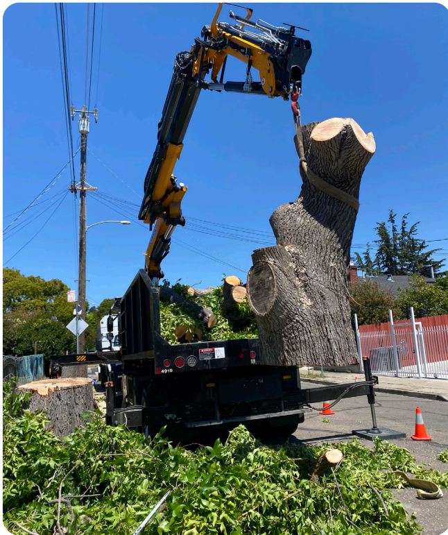
▲ 行道樹的維護和移除通常需要重型機械。
