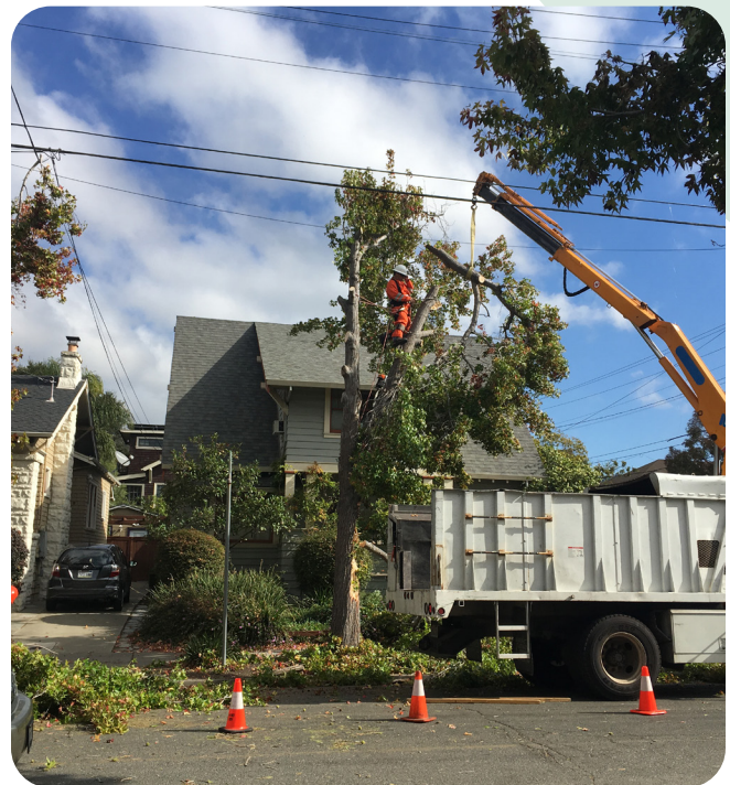
▲ Personal de la ciudad elimina un árbol peligroso en la calle con equipamiento de trabajo pesado.
