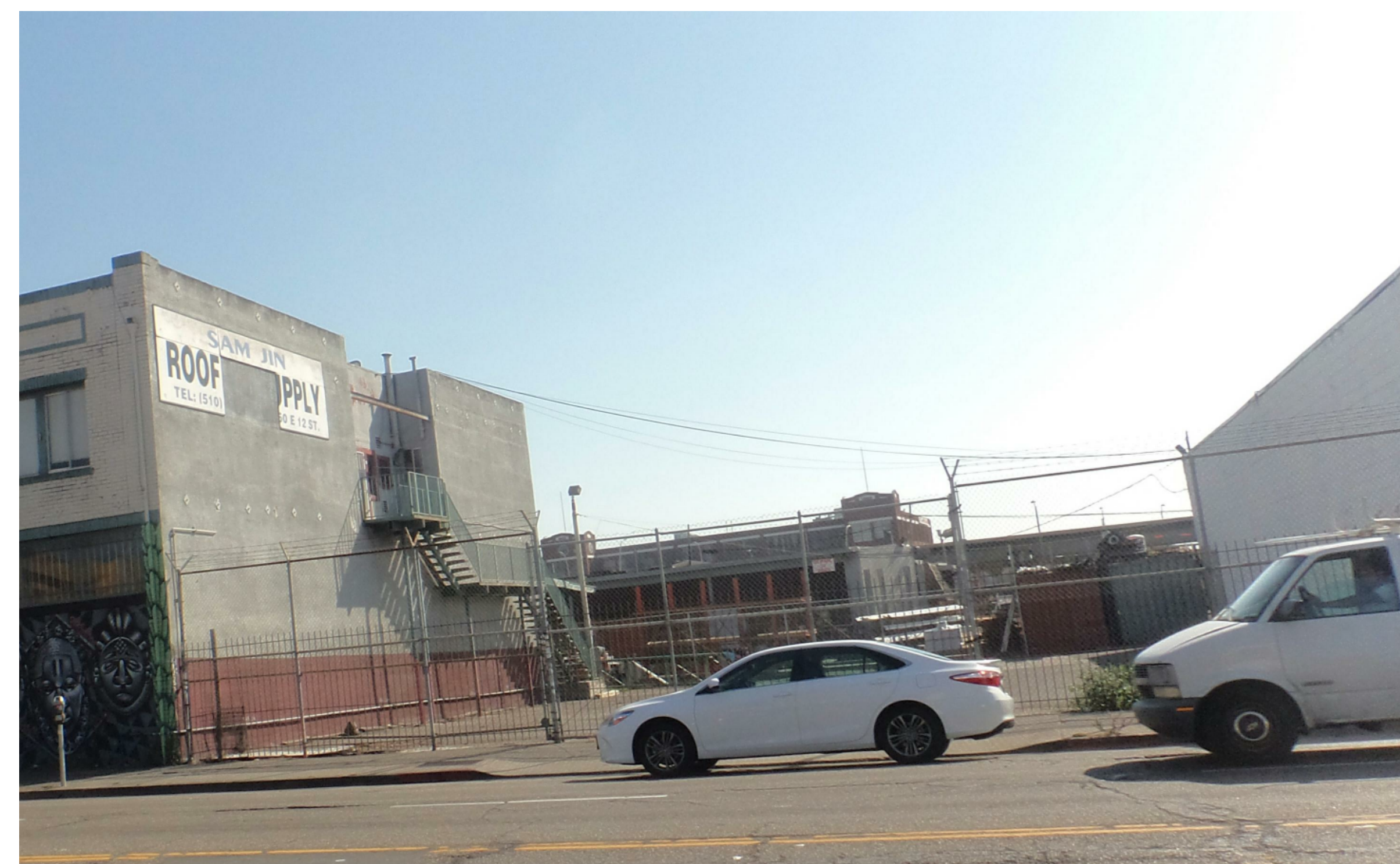
2249 INTERNATIONAL BOULEVARD EXISTING SITE
