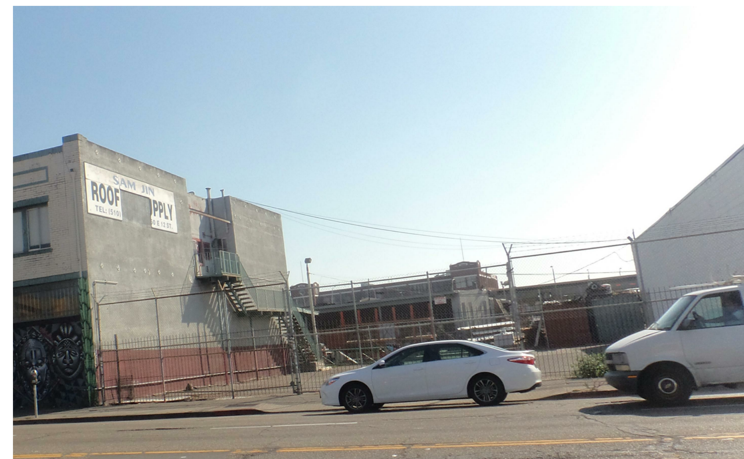
2249 INTERNATIONAL BOULEVARD EXISTING SITE
