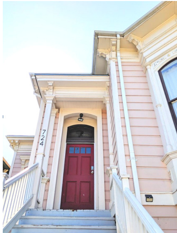
Front portico porch
