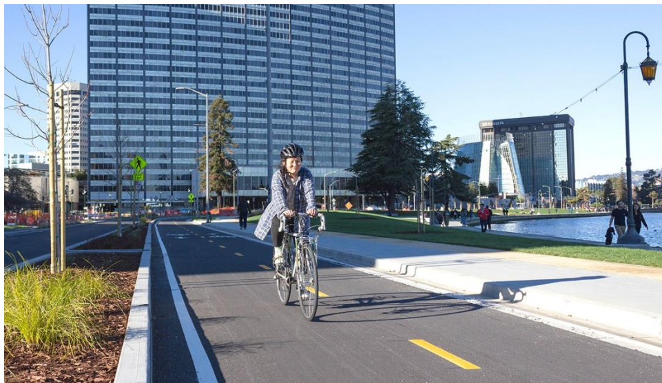
輕鬆騎車：Lakeside Dr 介於 Madison Street 和 Harrison Street 之間路段的分隔式自行車道。
