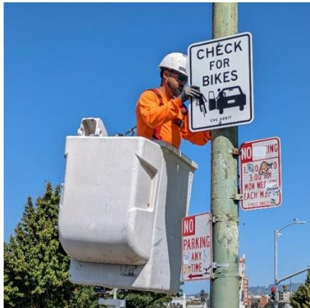
*Imagen: Equipo de mantenimiento de tráfico de la División de Calles Seguras instalando la señalización de Check for bikes en Lakeshore Ave.*
