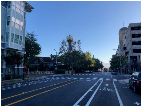
(arriba) Carriles para bicicletas con separación en el centro de MLK Jr Wy
