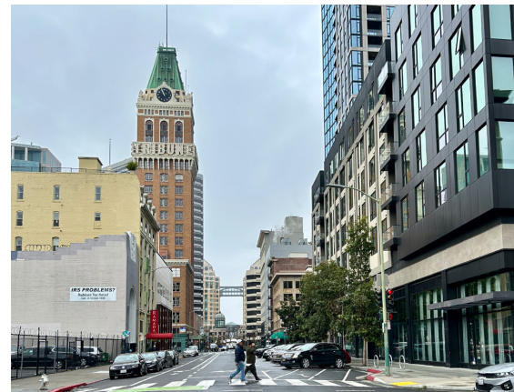
新配置的 13 th St 設有緩衝自行車道和後入式斜角停車道
