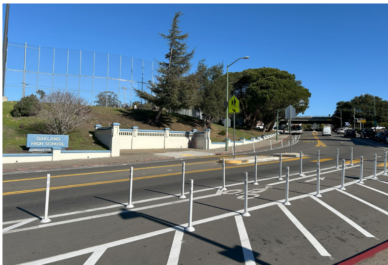
Park Blvd 的快速建造、自行車專用道及人行橫道改進工程
