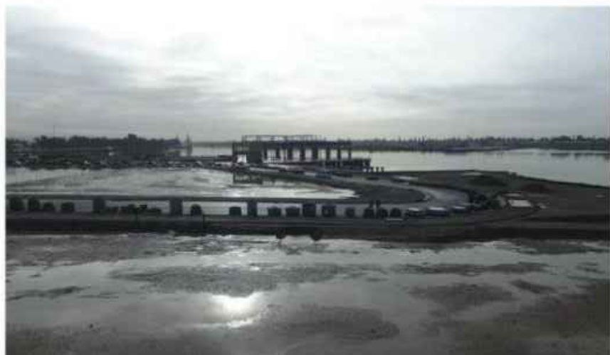
PARCEL J 7 Looking SE
