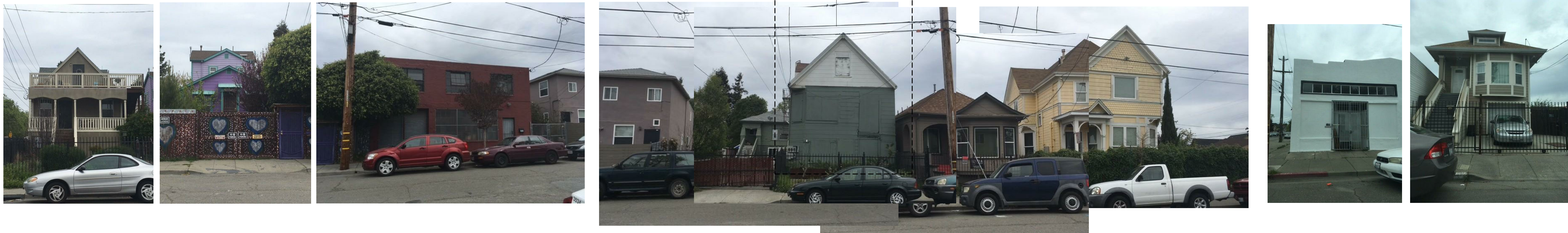
2 30TH STREET ELEVATION - SOUTH FACING scale: N.T.S.
