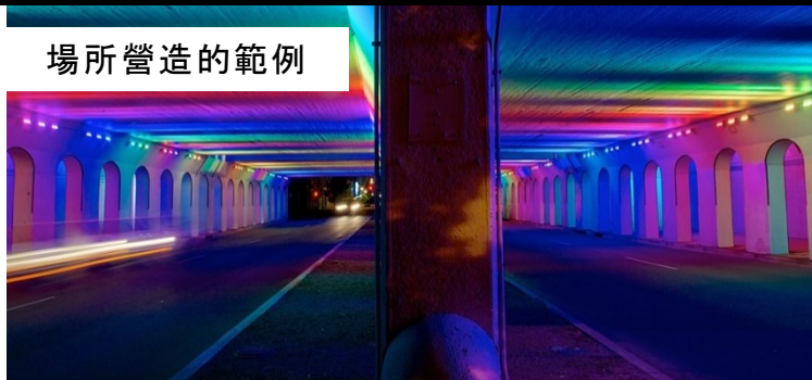
照明設備範例
