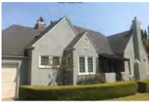
1200 Trestle Glen -Front
